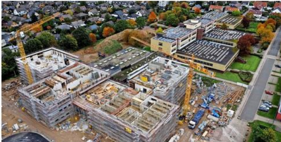
Der Neubau des Gymnasiums Sarsseck ist derzeit das größte Bauprojekt in der Schullandschaft im Kreis Hildesheim. Foto: Heiko Stamppe
